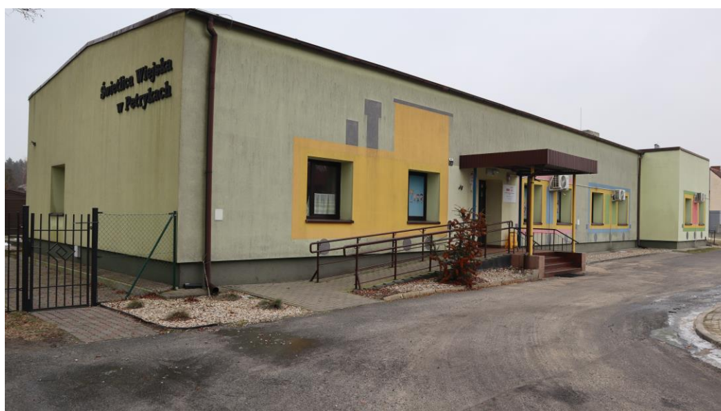
Świetlica wiejska w Petrykach
