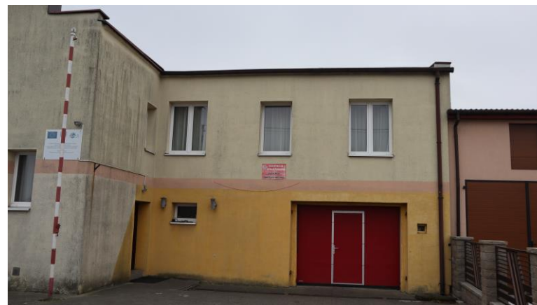
Świetlica wiejska połączona z remizą OSP w Piątku Małym.
